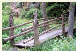
Die Brücke führt auf das Klostergelände
