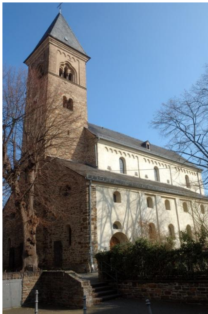
Vorbei an der romanischen alten St. Servatiuskirche
