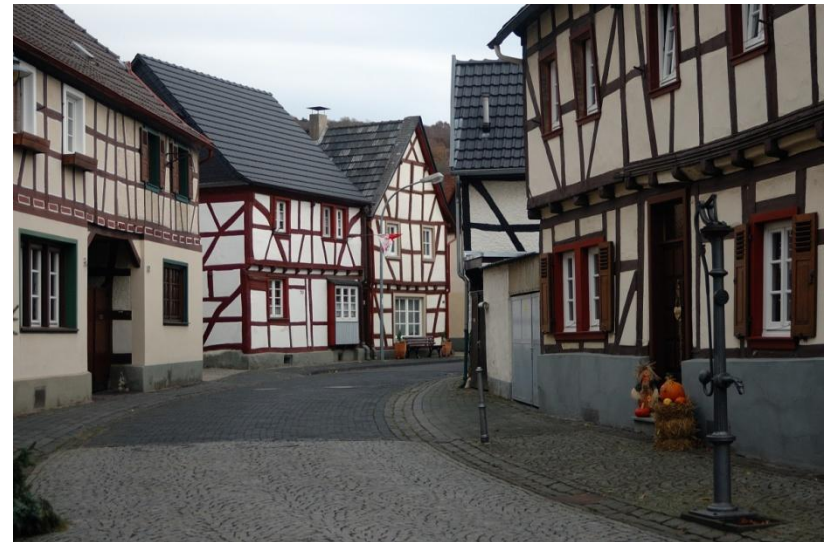
Ortsdurchquerung von Bad Bodendorf
