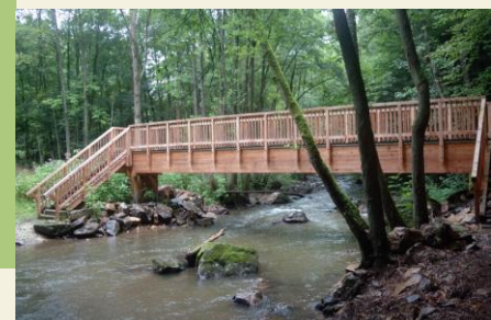
Brücke über den Simmerbach
