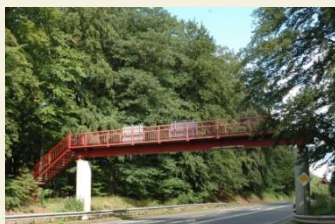
Fußgängerbrücke über die Hunsrückhöhenstraße (B327)
