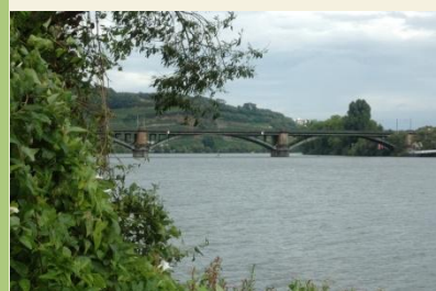
Die Güls Eisenbahnbrücke
